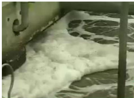
Figure 10 : la formation de mousses dans les bassins des stations d'épuration
