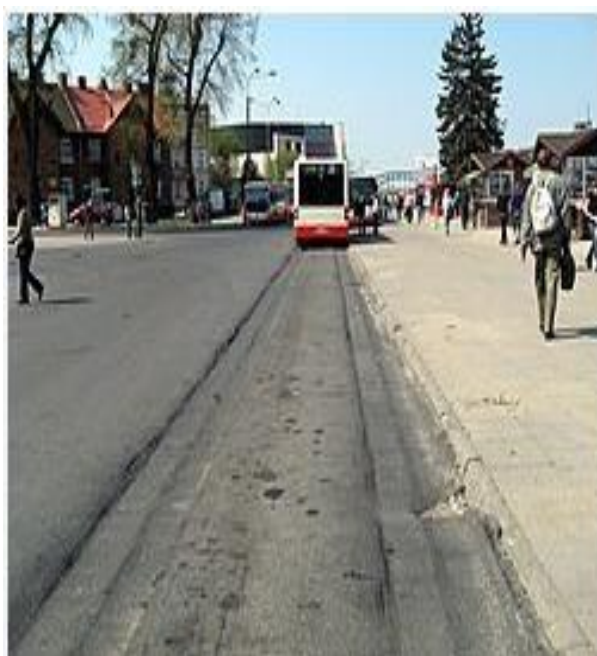
Figure II.7 : Exemple d'orniérage observé sur une chaussée souple (SETRA, 1994).
