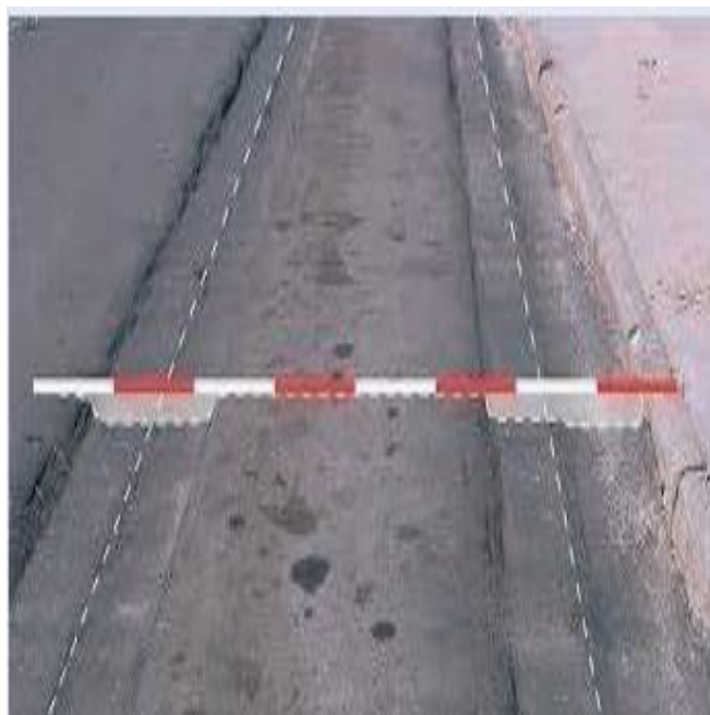
Figure II.7 : Exemple d'orniérage observé sur une chaussée souple (SETRA, 1994).
