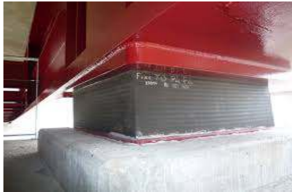
Figure IX.1. Photo réelle d'un appareil d'appuis
