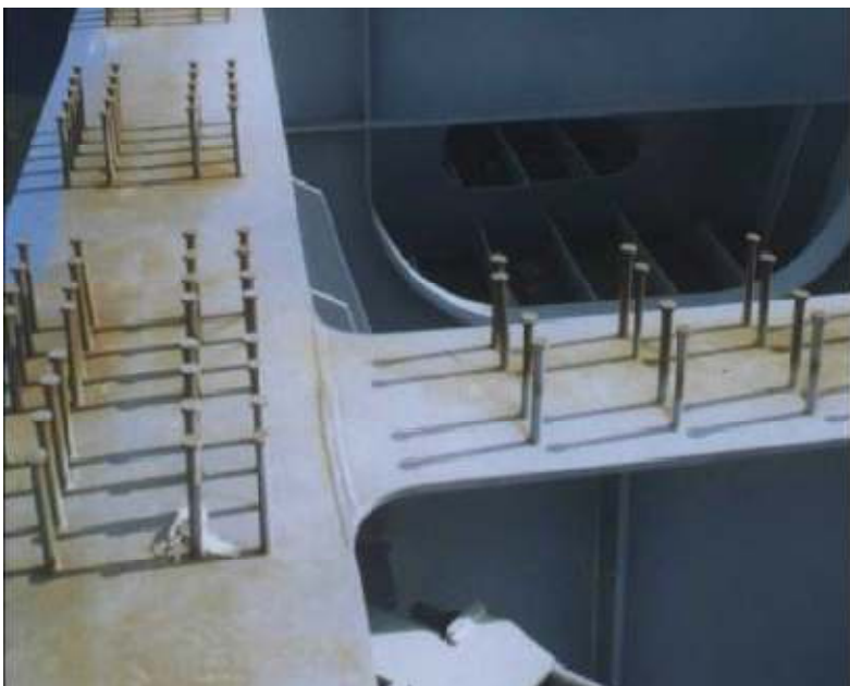
Figure IV.9 : Connecteurs de type goujons
