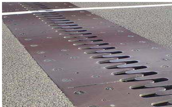
Figure IX.10. Joint de chaussée
