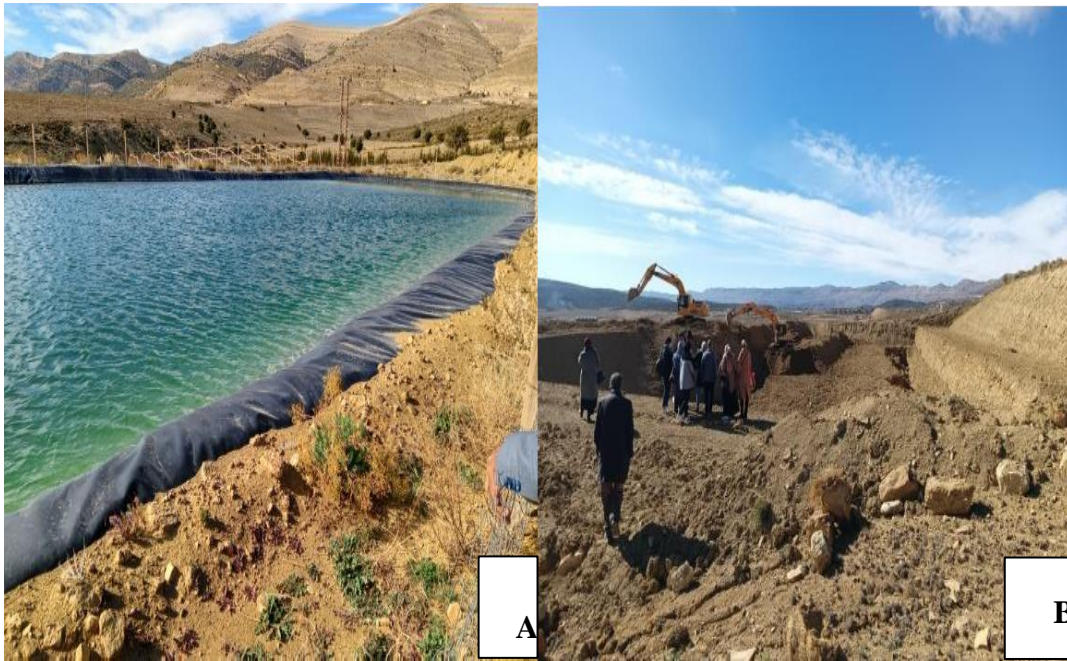
Figure04 : (A) un des géo membranes prêt à utiliser, (B) Géomembrane en cours de réalisations (Photos originales, 2023).
