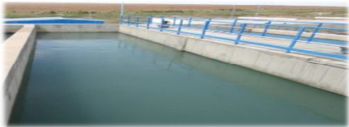
Figure 13 : Bassin de flocculation (MALAOUÏ et AGOUDJIL., 2014).
