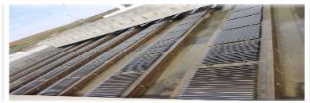
Figure 15: Décanteur lamellaire (MALAOUI et AGOUDJIL., 2014).
