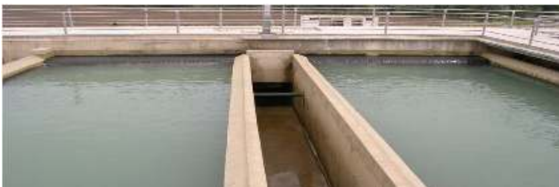
Figure 16 : Bassins de Filtration(MESSAOUDI et BOUZIDI., 2015).
