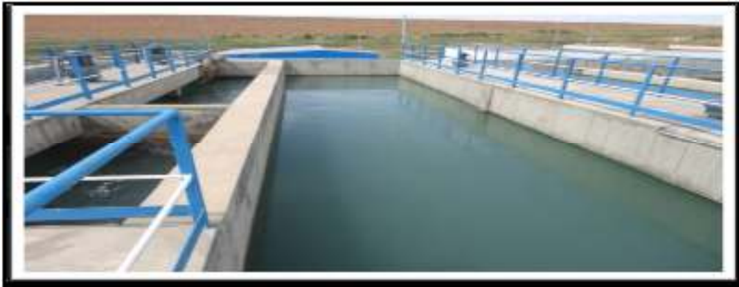
Figure 12 : Bassin de coagulation (MALAOUÏ et AGOUDJIL., 2014).
