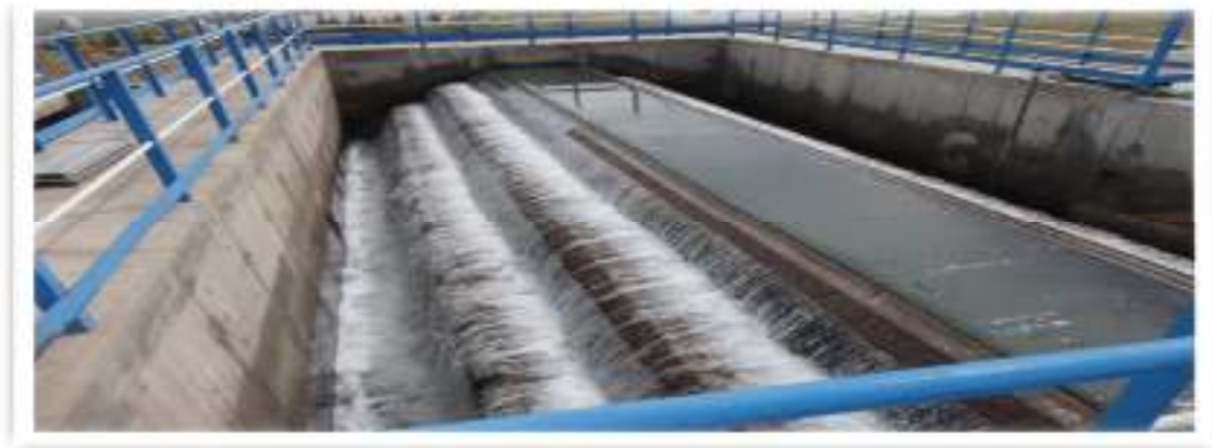
Figure 11 : Cascade d'aération (MALAOUI et AGOUBIL., 2014).
