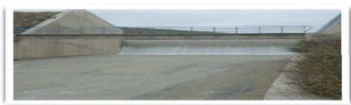
Figure 07 : Evacuateur de crue (MALAOUI et AGOUDJIL., 2014).
