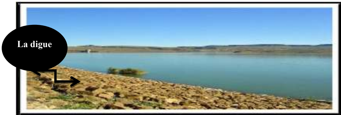
Figure 08 : la digue du barrage (MALAOUI et AGOUDJIL., 2014).
