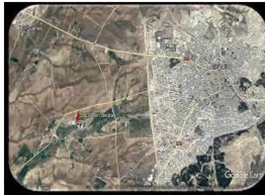
Figure III.1. : Vue de ciel de la station d'épuration d'Ain Beida
