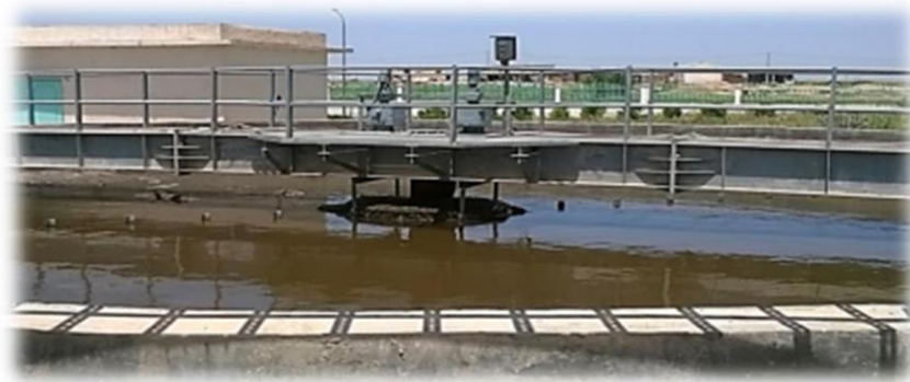
Figure III.16 :L'épaississeur secondaire.
