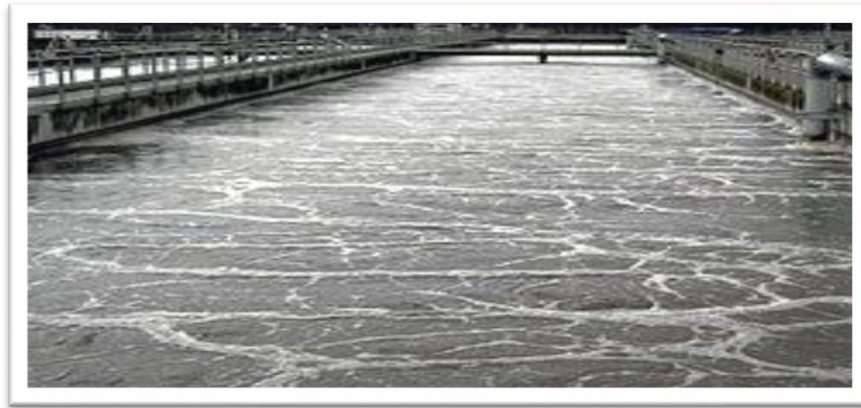
Figure II.6. Traitement biologique avec apport artificiel d'oxygène
