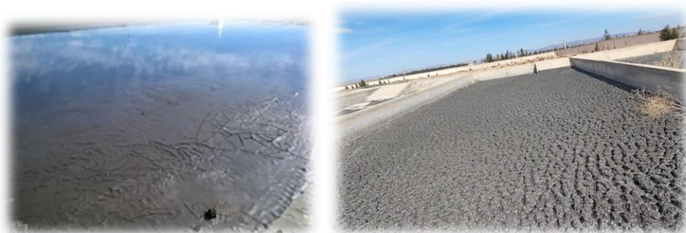
Figure III.17. Les Lits de séchage
