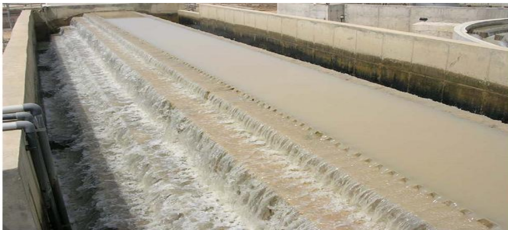
Photos 3.2. Cascades d'aération.
